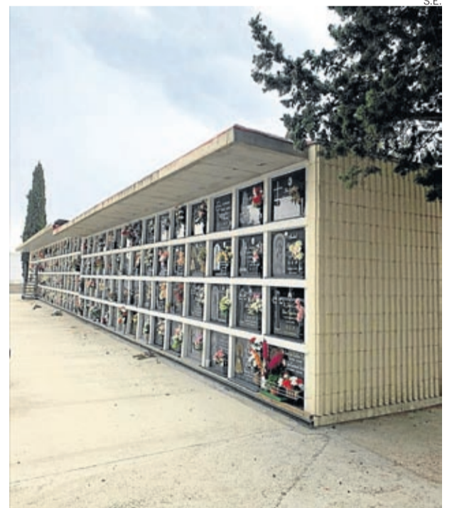
Se han reparado las humedades de un pabellón de nichos.
